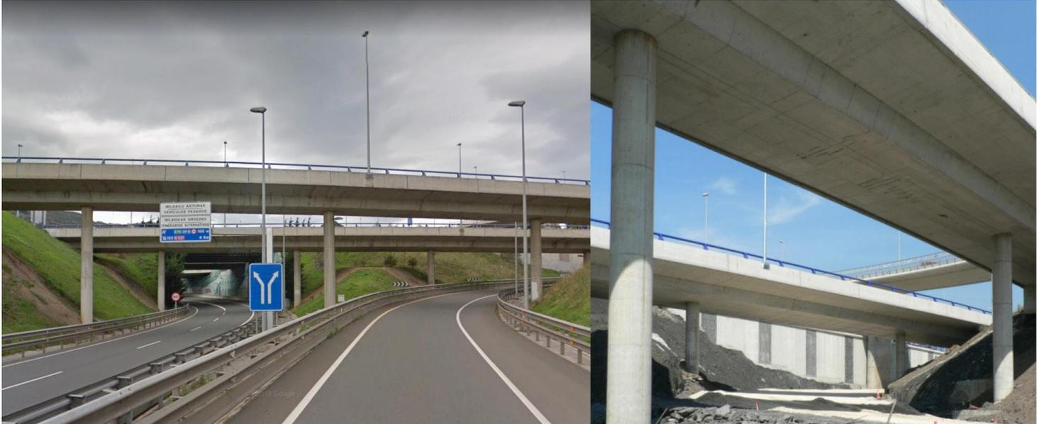
Las losas armadas aligeradas tienen una luz máxima de 23.00 m con cantos totales de 1.15 (L/20) y se han proyectado como puentes integrales. Así, se prescinde de la presencia de aparatos de apoyo y juntas de dilatación reduciendo con ello importantemente el coste de mantenimiento. Para ello, los fustes circulares se empotran en el tablero y los cargaderos, solidarios con éste, se cimentan mediante micropilotes.
